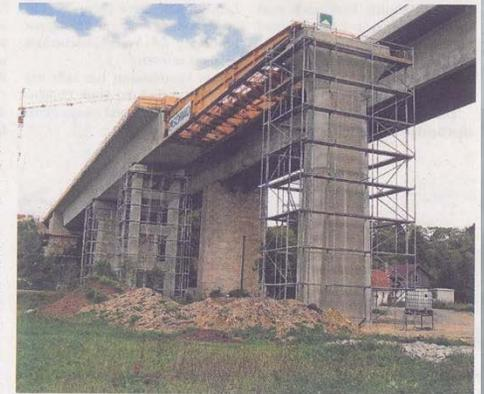
Die Brücke wird abschnittsweise vor Ort in Beton gegossen und mithilfe einer Stahlkonstruktion (im Bild gelb) von Pfeiler zu Pfeiler weitergebaut.
